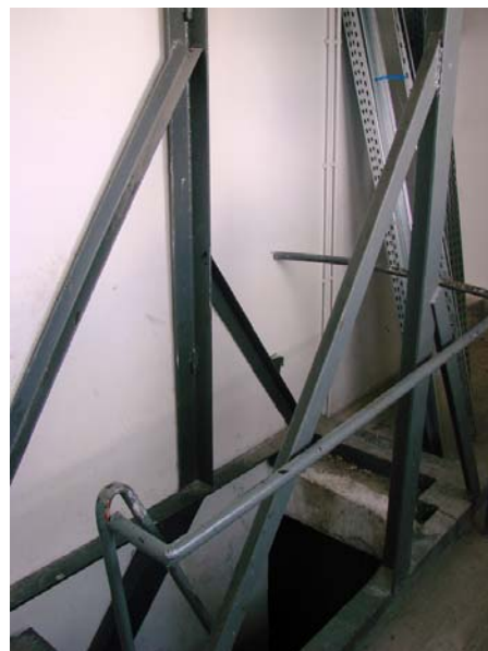
konstrukcja nad schodami
