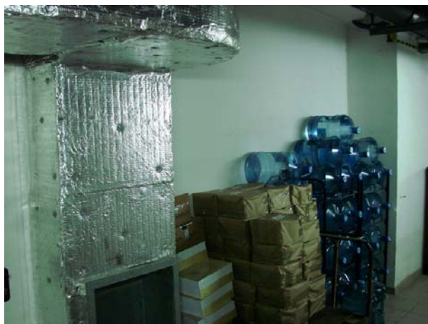
ściana szybu od strony korytarza piwnicy
