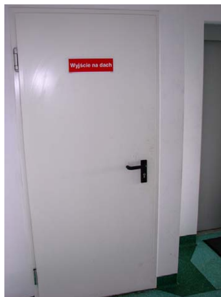
wejście na dach
