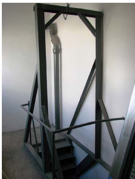
konstrukcja nad schodami
