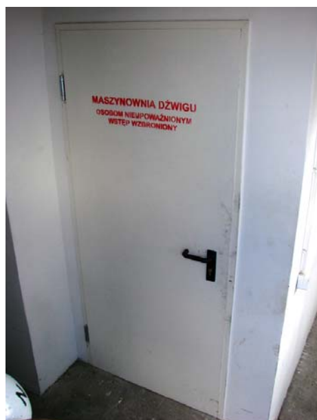
wejście do maszynowni
