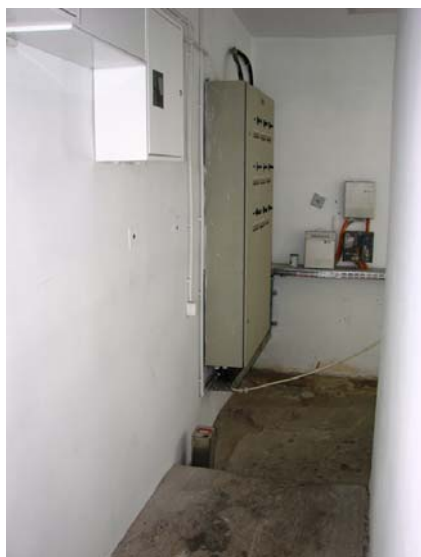
korytarz prowadzący na dach i do maszynowni
