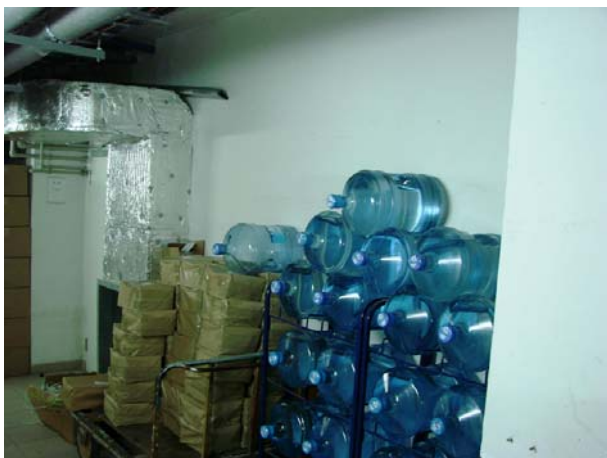
ściana szybu od strony korytarza piwnicy
