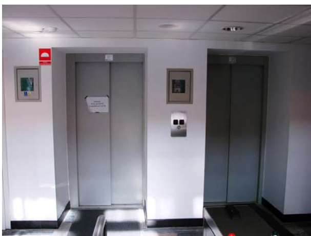
drzwi dźwigów na parterze
