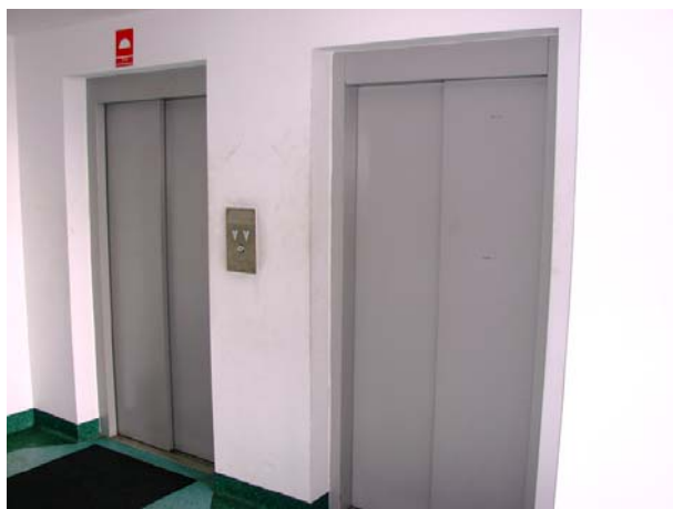
drzwi dźwigów na XII piętrze
