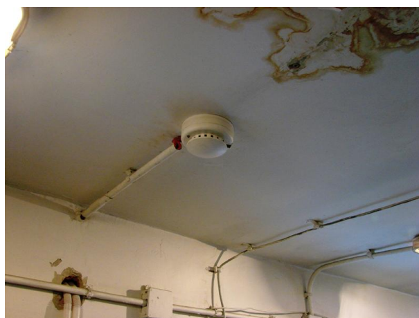
czujka systemu sygnalizacji p.poż.
