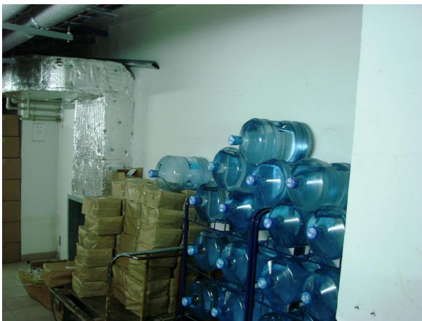
ściana szybu od strony korytarza piwnicy
