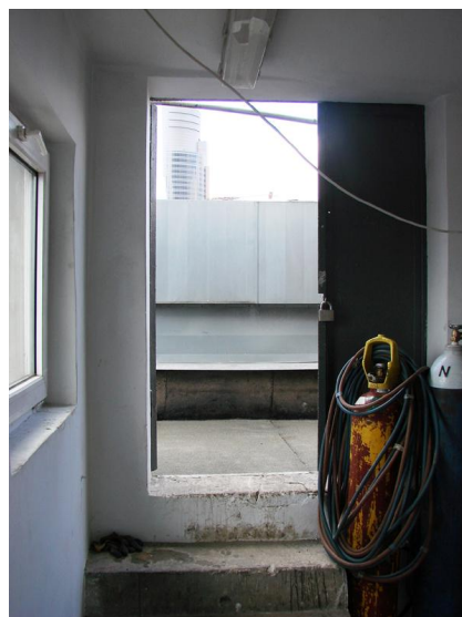
wejście na dach
