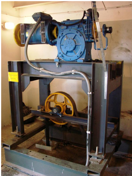
napęd dźwigu nr 1
