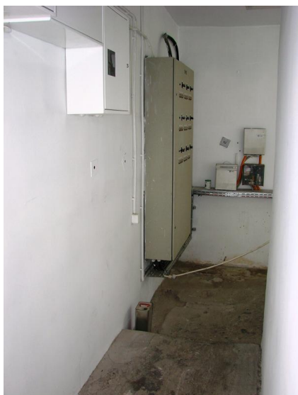
korytarz prowadzący na dach i do maszynowni
