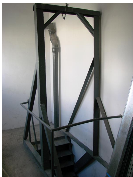
konstrukcja nad schodami
