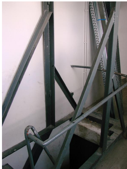
konstrukcja nad schodami
