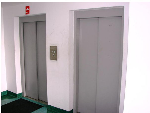
drzwi dźwigów na XII piętrze
