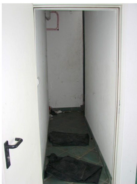
korytarz za drzwiami
