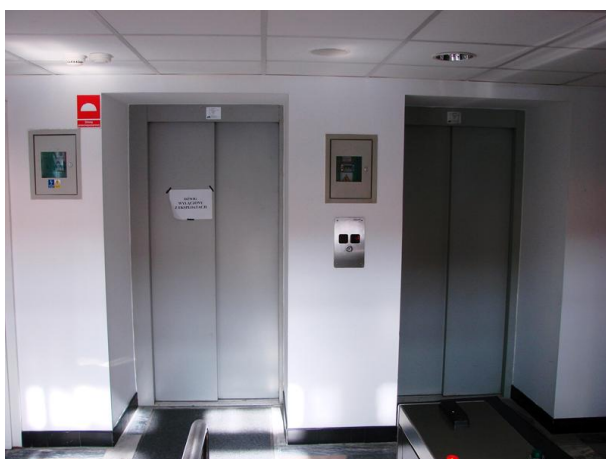
drzwi dźwigów na parterze
