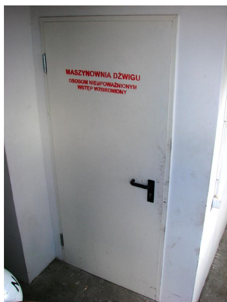
wejście do maszynowni
