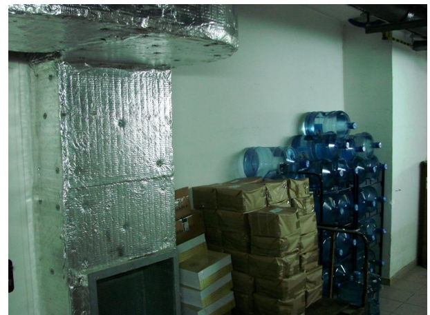
ściana szybu od strony korytarza piwnicy
