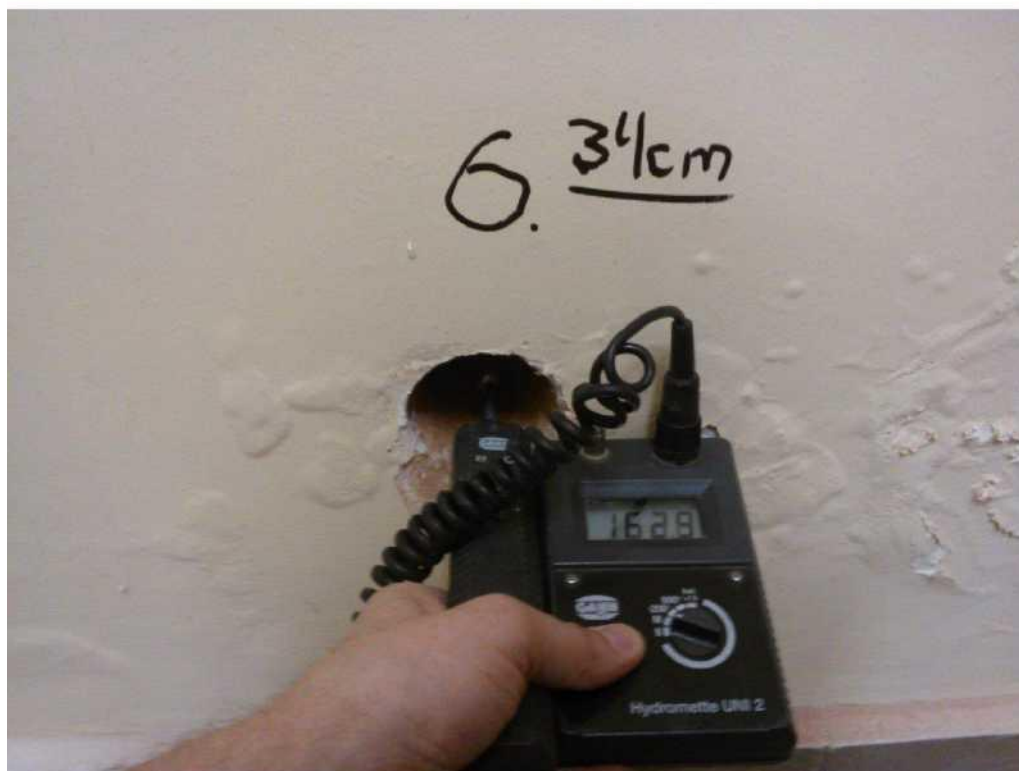
Rys. 2. Miejsca wykonania pomiaru wilgotności oraz miejsca odwiertów których próbki posłużyły do określenia zawartości szkodliwych soli budowlanych.
